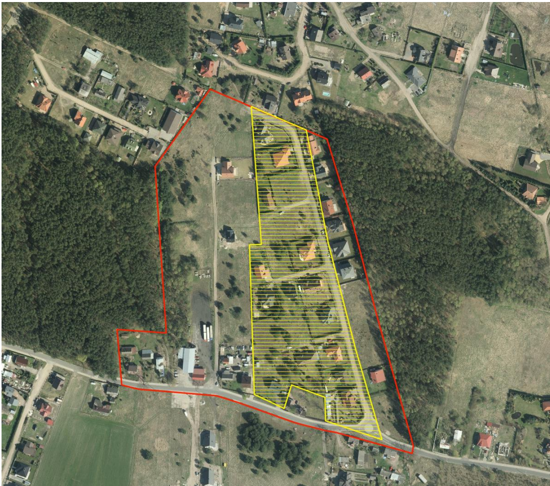
Obszar objęty miejscowym planem zagospodarowania przestrzennego – plan przyjęty uchwałą nr XXII/151/2000 Rady Gminy Białe Błota z dnia 5 czerwca 2000 r. w sprawie miejscowych planów zagospodarowania przestrzennego obejmujących tereny we wsi Zielonka jako zmiany dotychczas obowiązującego miejscowego planu ogólnego zagospodarowania przestrzennego gminy Białe Błota (źródło ortofotomapy: usługa wms serwisu geoportal.gov.pl ).
